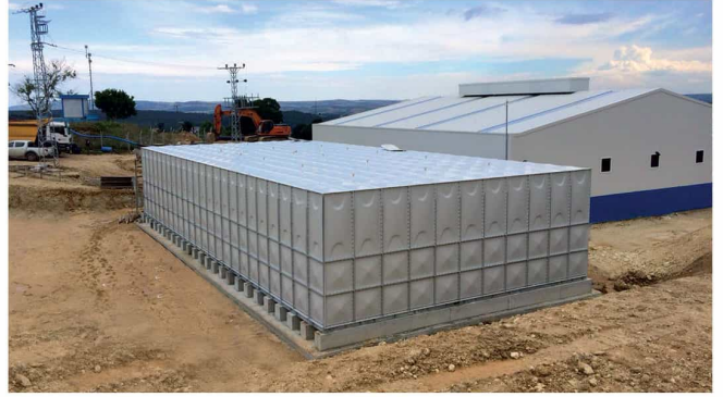
■ Üst Çatı Panellerin Tamamlanması
