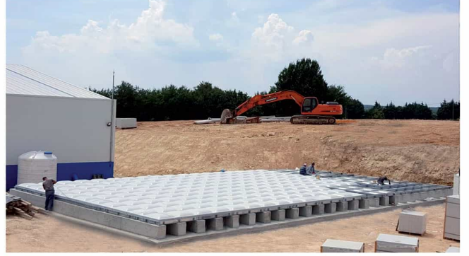
■ Taban Çelik Kaide Panel Uygulaması
